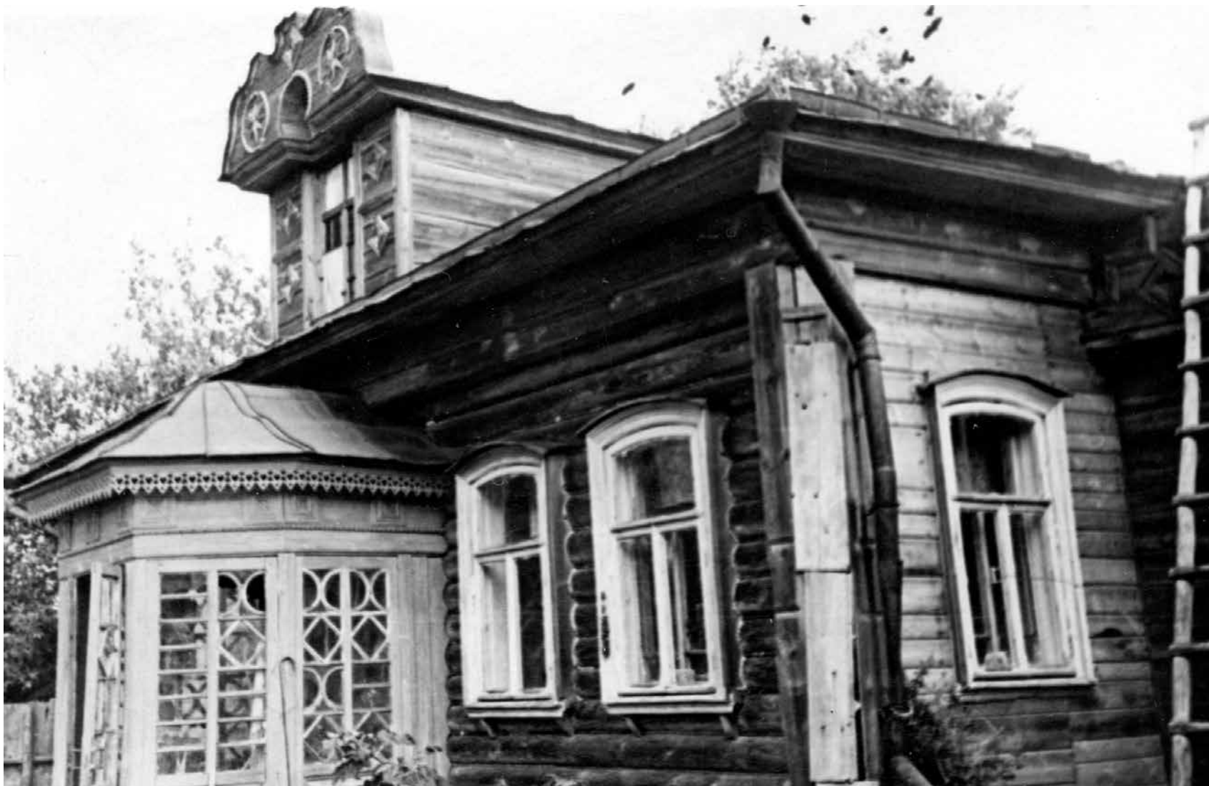
Жилой дом. «Парадный» вход, д.Кадышево
